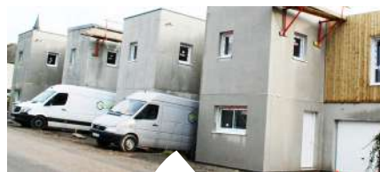
Construction de 4 logement sociaux par la commune de Baulon
