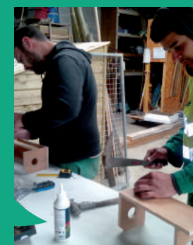
À Guichen, l'entretien du bâti
